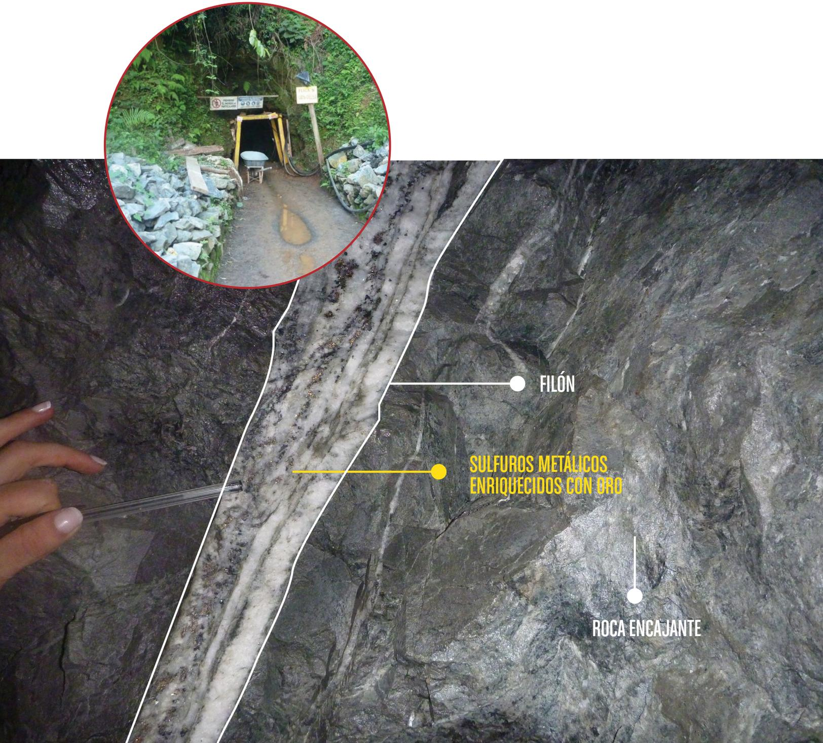
Figura 4.6: Diagrama frente de mina unidad geometalúrgica 3.
