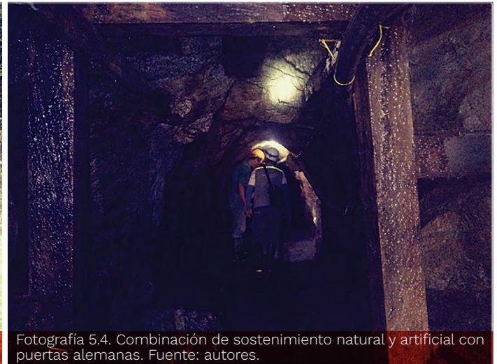
Fotografía 5.4. Combinación de sostenimiento natural y artificial con puertas alemanas. Fuente: autores.
