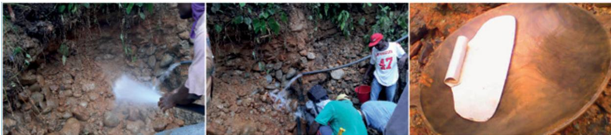
Fotografía 5.7. a) beneficio del material por gravedad con canalones. b) el agua se lleva hasta el punto de trabajo con motobombas o por gravedad
