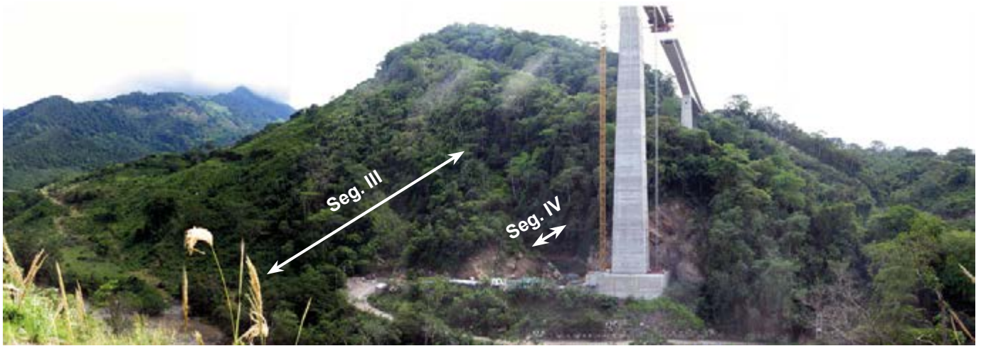
Figura 10. Vista general de los afloramientos de la Formación Tablazo en el estribo sur del puente nuevo El Tablazo. En este sector la sucesión se levantó y se describió a partir del metro 113 y hasta el metro 174, de los cuales 36 m corresponden a parte del segmento III, y 25 m a la totalidad del segmento IV. Fotografía tomada desde el punto con coordenadas N:1.270.286, E:1.081.397 y azimut: 195°.
