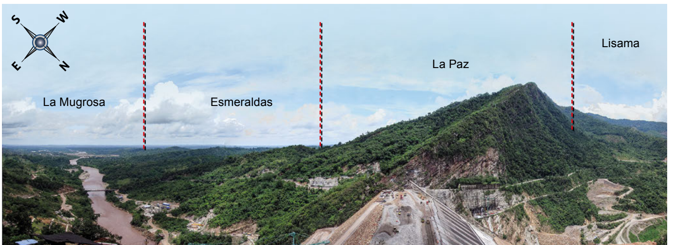
Figura 13. Panorámica de las unidades del Paleógeno-Neógeno a lo largo del cañón del río Sogamoso, contiguas a la presa Hidrosogamoso (N:1.276.735, E:1.073.992, Z:395).
