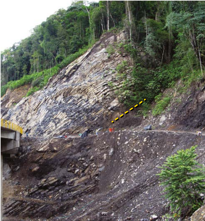
Figura 94. Contacto entre las Formaciones La Paja y Tablazo en el puente sobre la quebrada La Molinilla (N:1.279.751, E:1.085.505, Z:527). Nótese en los metros cuspidales de la Formación La Paja un conjunto intermedio que genera resalte (esquina inferior izquierda), similar en litología y presentación a las rocas basales de la Formación Tablazo.
