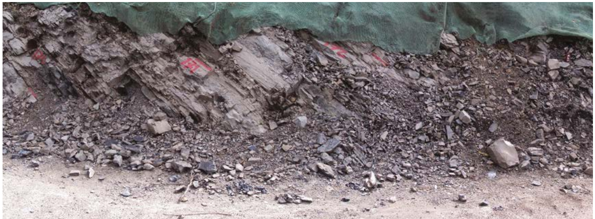
Figura 51. Parte inferior del segmento 10, wackestone de coloración gris parduzca, en capas delgadas, planas paralelas discontinuas, parcialmente cubierto con mallas sobre las cuales se siembra pasto para su estabilización geotécnica; Formación Galembó, m270,0-m274,0 (N:1.263.706, E:1.076.200, Z:446, Az:275°).
