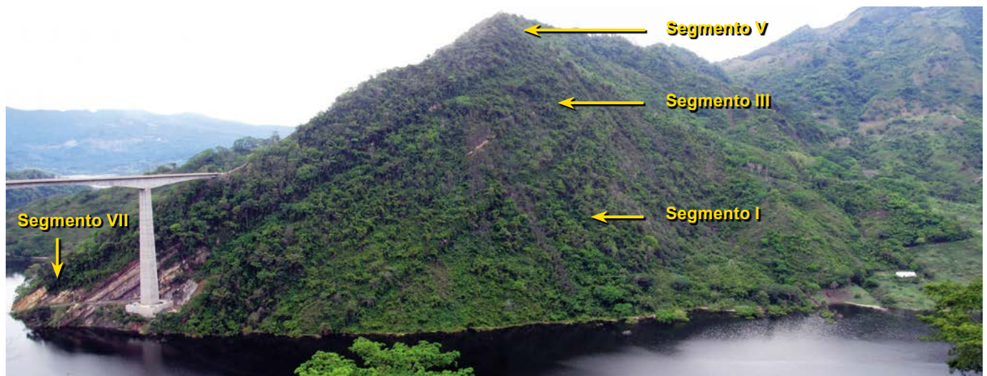
Figura 1. Panorámica de la Formación Tablazo en el cerro homónimo (sección tipo). Obsérvese la morfología de montaña que genera la unidad. El espejo de aguas pertenece al embalse de Hidrosogamoso. Puente El Tablazo (fotografía tomada desde el punto con coordenadas N:1.269.590, E:1.081.550 y azimut 345°).
