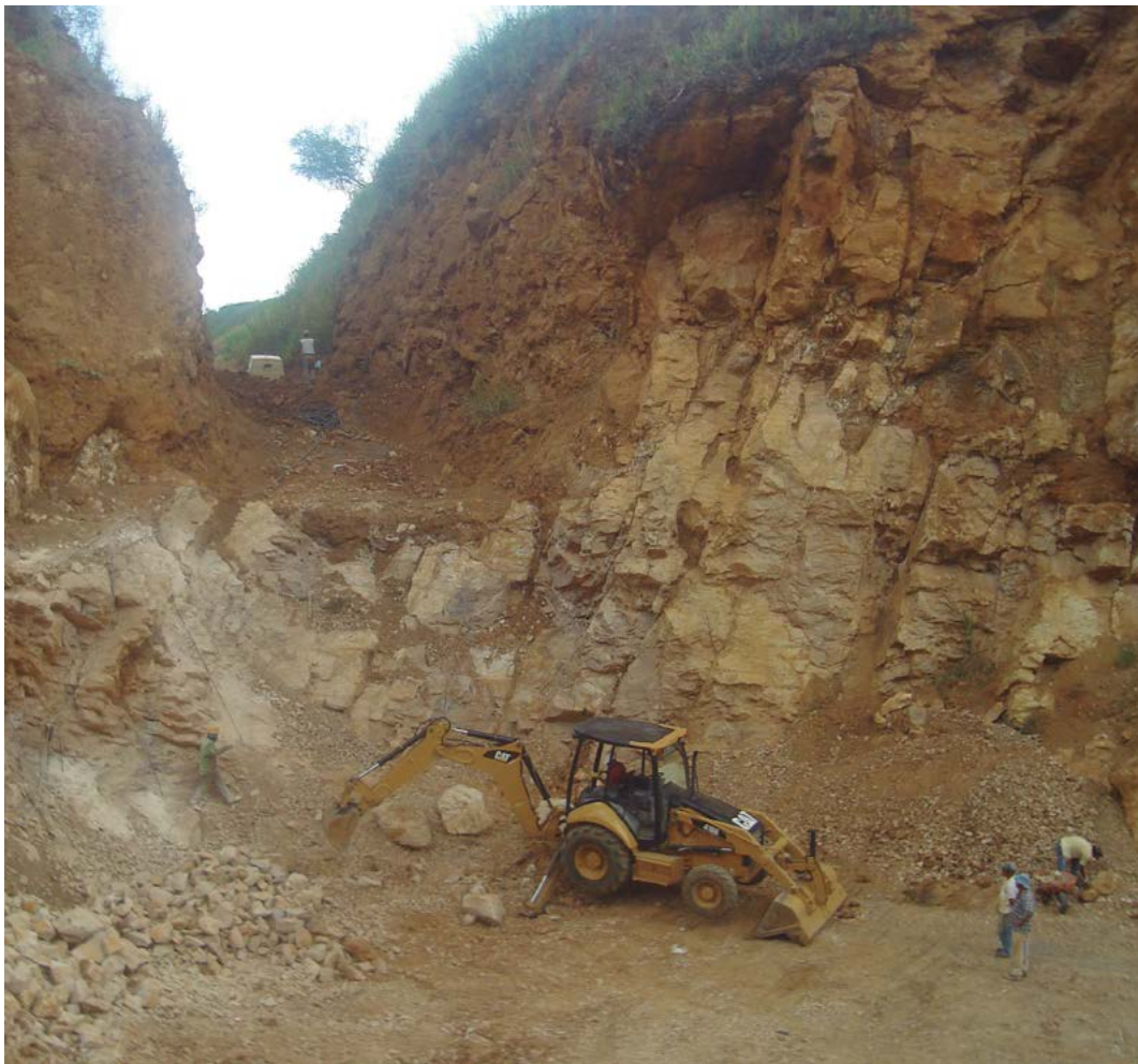
111 Cantera de materiales de construcción (Otengá, Boyacá) Fuente: archivo SGC
