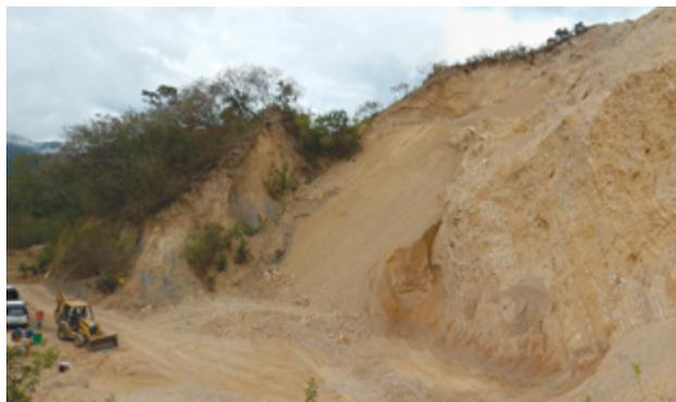
**Figura 4.** Fotografía de extracción de material en canteras en la vía Coello-Chicoral, margen vial derecha. Material de explotación de cantera correspondiente a la formación Lidita Superior del Grupo Olini. Se observa una separación de dos paquetes de roca: hacia la parte superior, porcelanitas y areniscas fosfáticas, y en la parte inferior, niveles de chert y lodolitas. Vista hacia la 65.ª Estación Geológica EG-1176, N = 958 297, E = 902 683 Cota = 443 m. s. n. m.
