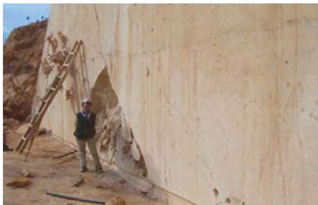
**Figura 12.** Corte vertical simple usando la técnica de hilo diamantado. Formación La Tampa. Eoceno Medio (Colombia)
