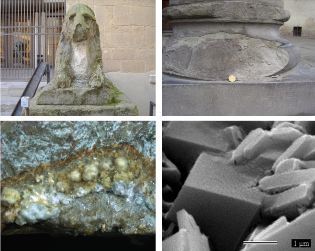
**Figura 5.** Alteración de la arenisca piedra serena por agentes biológicos y medioambientales. Alteración biológica (superior izquierda); procesos de arenización y exfoliación (superior derecha). Eflorescencias salinas en calizas ornamentales (inferior izquierda); imagen de SEM que muestra corrosión de cristales de calcita por yeso neoformado en ensayo de envejecimiento por acción del  $\text{SO}_2$  (inferior derecha)
