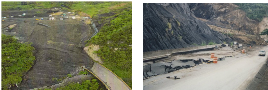
Figura 20. Deslizamiento compuesto progresivo de Cune en rocas lodosas. Movimiento y masa desplazada (izquierda). Pata del movimiento con terminación ascendente (derecha).
