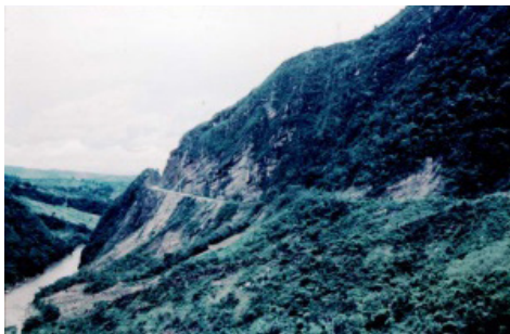
Fotografía 15. Desprendimiento de rocas por exposición de diaclasas de relajación en cortes viales.
