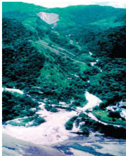
Fotografía 28. Deslizamiento rotacional-flujo de detritos en el borde llanero, sitio el Mirador (carretera Bogotá-Villavicencio).
