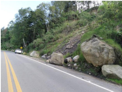
Fotografía 17. Bloques rodados que invaden la carretera en proximidad de la población de Honda. Se pueden ver bloques expuestos al pie de talud (posiblemente reacomodados) (izquierda) y obstrucción de alcantarillas por torrentes de bloques (derecha).
