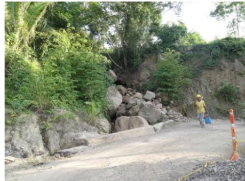
Fotografía 17. Bloques rodados que invaden la carretera en proximidad de la población de Honda. Se pueden ver bloques expuestos al pie de talud (posiblemente reacomodados) (izquierda) y obstrucción de alcantarillas por torrentes de bloques (derecha).
