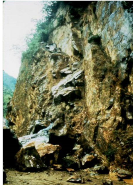
Fotografía 14. Caídas de rocas en carreteras: izquierda, en talud de rocas lodosas, La Vega (Cundinamarca), y derecha, en talud de diabasas, en el cruce del río Guáitara (Nariño).
