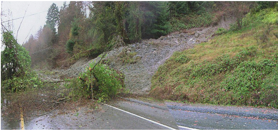
Fotografía 5. Deslizamiento por flujo en tilita glacial, desencadenado por alta presión de poros, en enero de 2005. Press Road, West Vancouver (Canadá).
