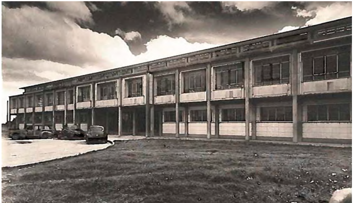
Fachada principal del Edificio del Laboratorio Químico Nacional en 1945.
