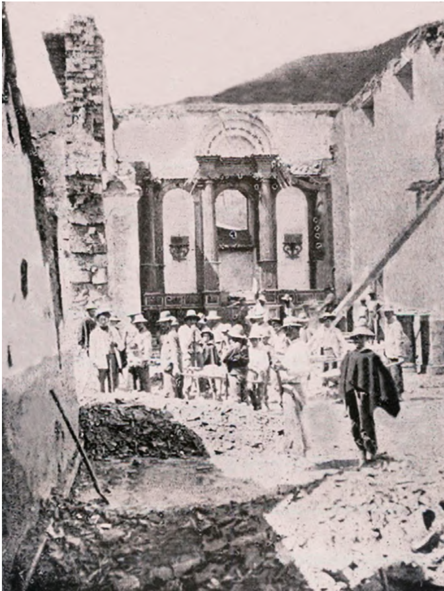
Ruinas de la iglesia de Gachalá (Cundinamarca) tras el terremoto del 22 de diciembre de 1923. Sarasola (1924).
