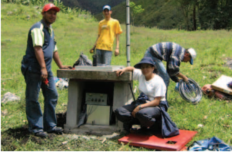
Foto 6. Monitor de flujos de lodo Calderitas, sobre el río Símbola.
