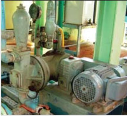
Figura 5.8. Bomba del tanque de pulpa lixiviada.
