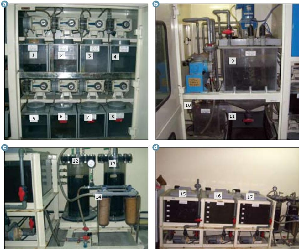
**Figura 13.5.** Las partes numeradas corresponden a: 1. Tanque  $H_2SO_4$ ; 2. Tanque MHG; 3. Tanque PAC; 4. Tanque coagulante; 5. Tanque NaOH; 6. Tanque  $NaHSO_3$ ; 7. Tanque NaOCl; 8. Tanque floculante; 9. Reactor; 10. Tanque electrolítico y flotador; 11. Tanque de filtrado; 12. Cámara de mercurio; 13. Cámara de carbón activado y 14. Microfiltros; 15. Tanque de agua tratada; 16. Tanque de agua ácida y 17. Tanque de agua alcalina.
