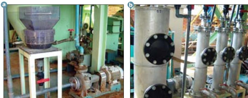
**Figura 7.1.** Unidad de precipitación y adsorción de oro: **a.** Sistema Merrill Crowe. **b.** Columnas de adsorción.
