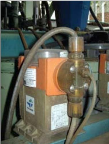
**Figura 8.8.** Bomba de los tanques de NaOH,  $H_2SO_4$ , NaOCl, floculante.
