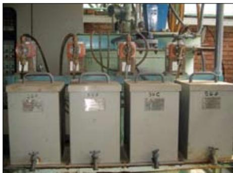
**Figura 8.6.** Tanques de almacenamiento de reactivos químicos para tratamiento de residuos (NaOH, H<sub>2</sub>SO<sub>4</sub>, NaOCl, floculante.)
