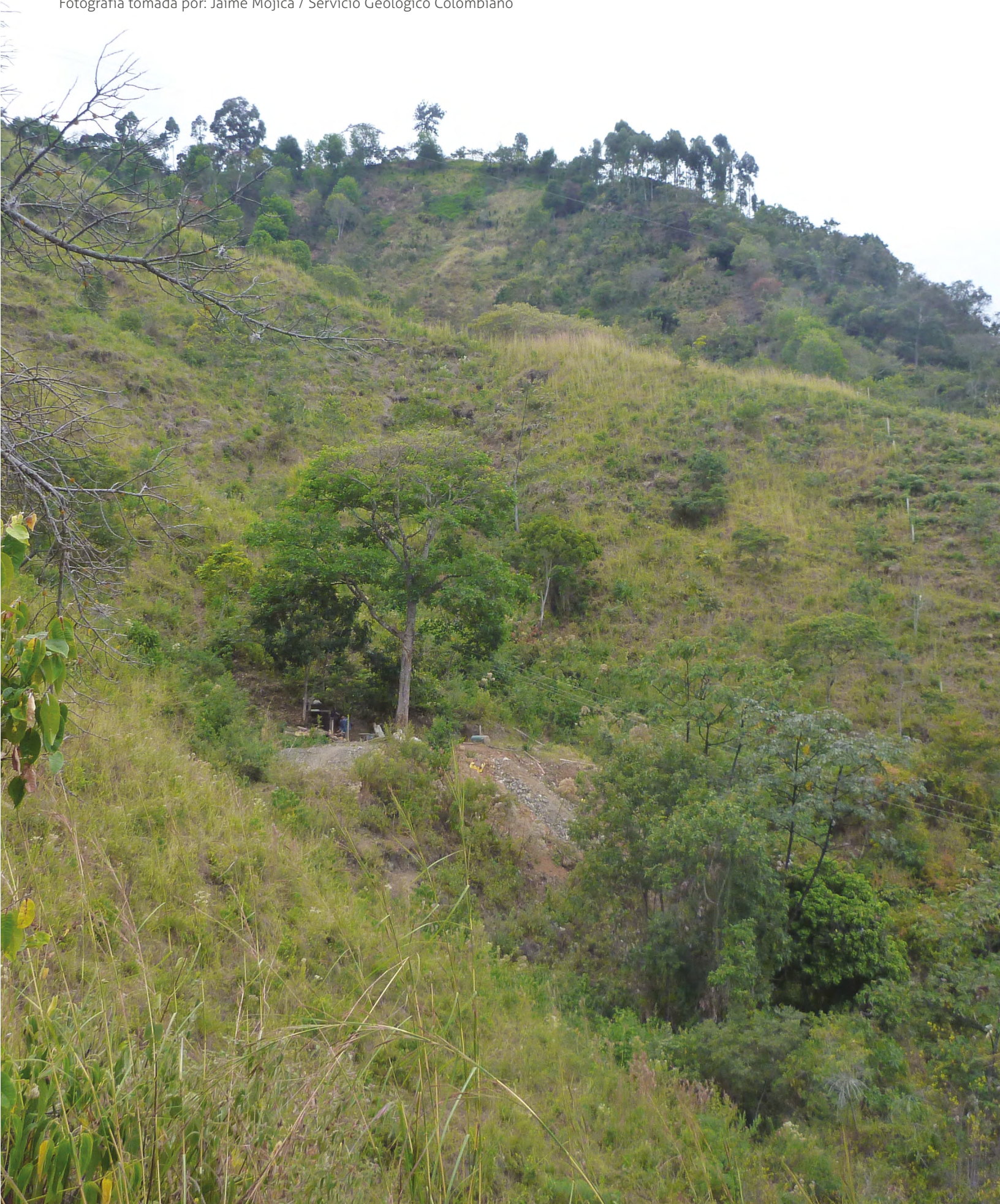
Panorámica de la cordillera donde se ubica una bocamina en la zona minera de Íquira (Huila). Fotografía tomada por: Jaime Mojica / Servicio Geológico Colombiano
