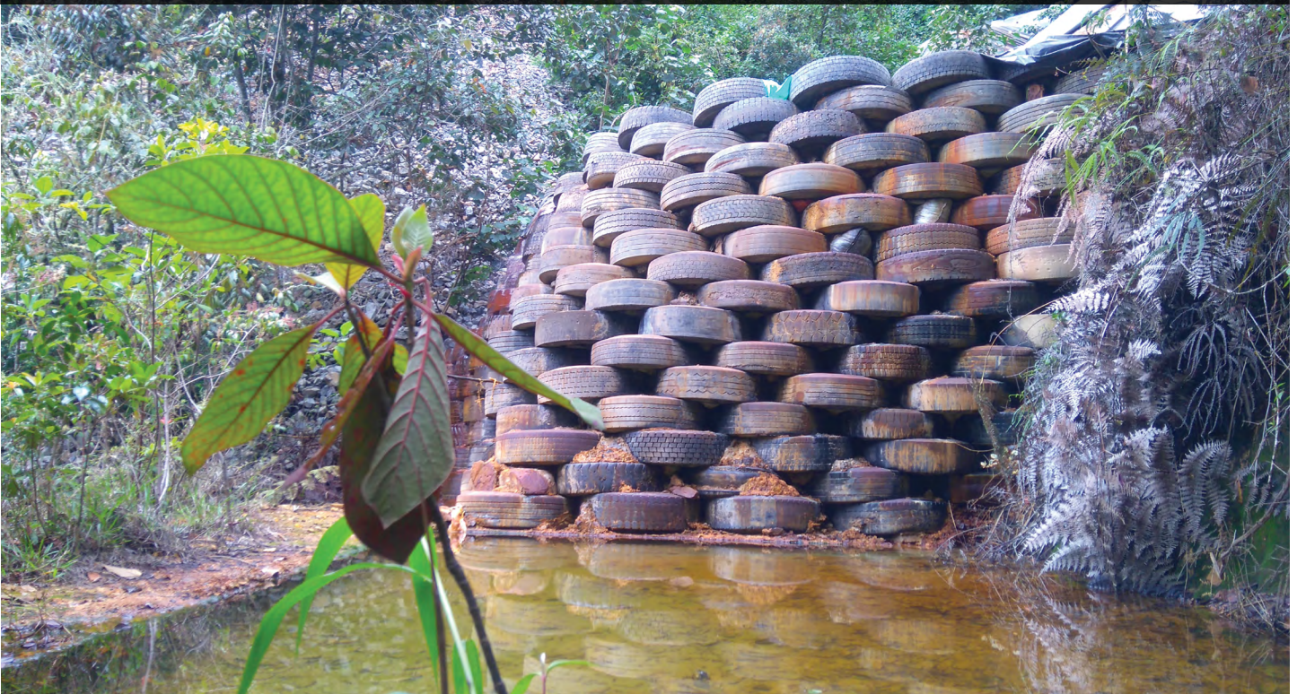
Fotografía 20: Piscina de agua en la planta El Cisne - aguas abajo. Hidróxido resultante de la descomposición de sulfato. Fuente: Propia.
