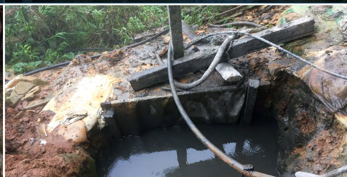
Fotografía 6.17. Tanque sedimentador. Fuente: autores.
