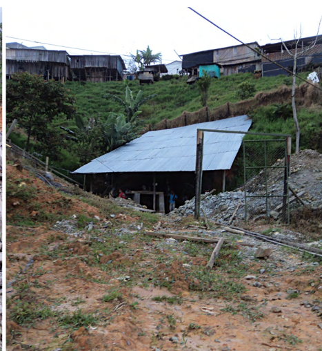
Fotografía 5.10. Techos de protección de la bocamina. Fuente: autores.
