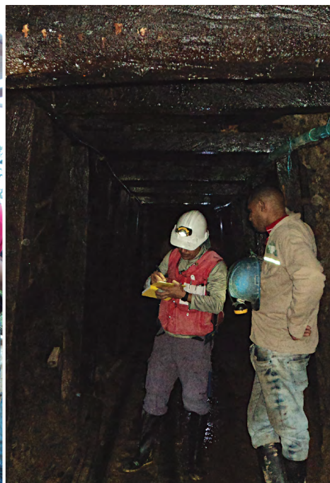
Fotografía 5.3. Sección de trabajo de 2 x 1.50m de ancho en cruzada. Fuente: autores.
