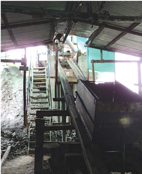
Fotografía 5.11. Coche y malacate de transporte de material. Fuente: autores.
