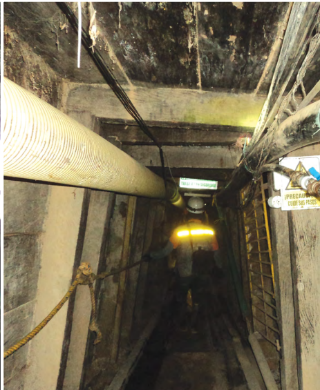
Fotografía 5.12. Inclinado para acceso a labores mineras. Fuente: autores.
