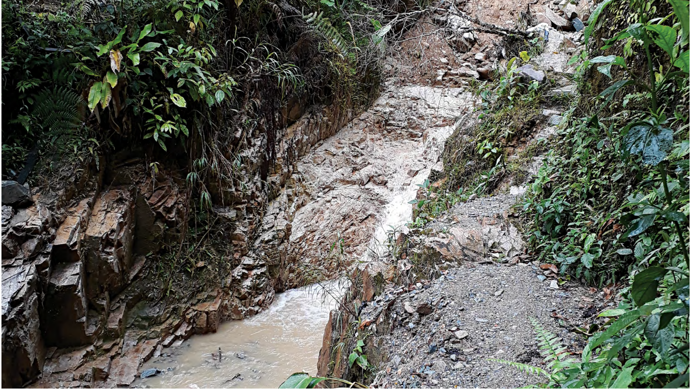
Fotografía 7.1. Panorámica aguas abajo de la quebrada La Estrella, sector de mina Caribe. Fuente: autores.
