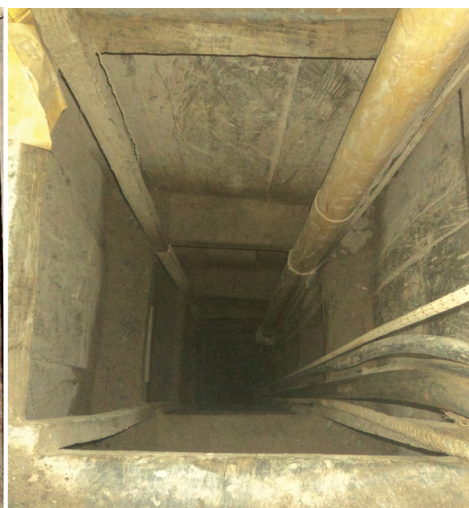
Fotografía 5.6. Clavada de acceso de personal y extracción. Fuente: autores.
