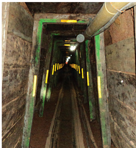
Fotografía 5.5. Sostenimiento con puerta alemana. Fuente: autores.
