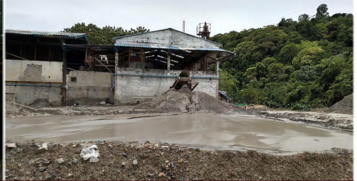
Fotografía 7.10. Patio de colas de cianuración de la planta El Limón. Fuente: Autores.
