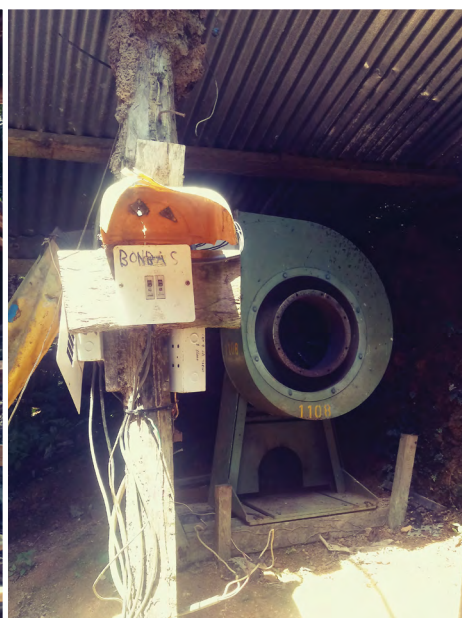
Fotografía 5.6. Ventilador helicoidal tipo búfalo. Fuente: autores.
