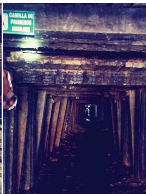
Fotografía 5.14. Sostenimiento con puertas alemanas. Fuente: autores.
