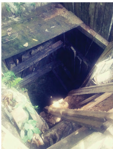
Fotografía 5.4. Bocamina Oro verde 1. Fuente: autores.
