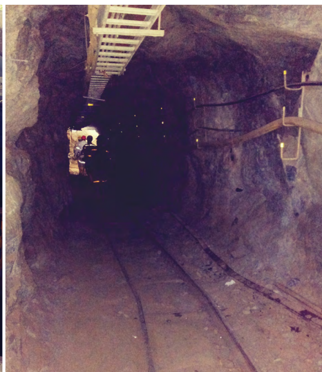
Fotografía 5.20. Sostenimiento natural. Fuente: autores.
