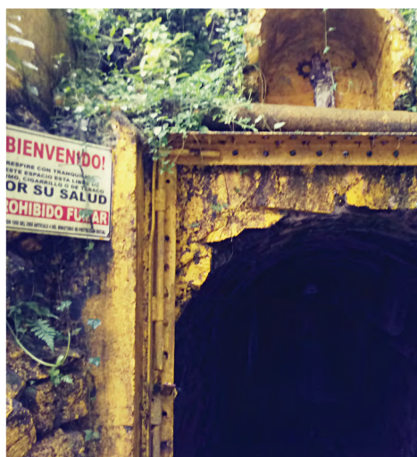
Fotografía 5.16. Bocamina con puerta de seguridad. Fuente: autores.
