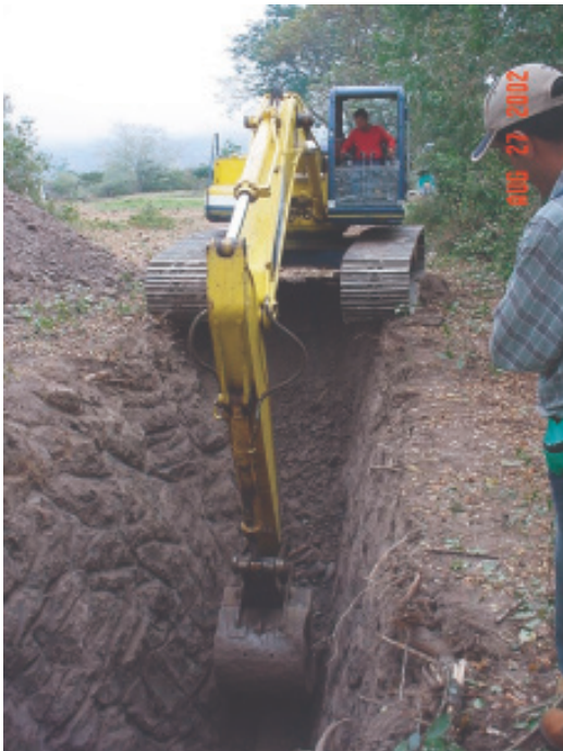
Figura 31. La excavación en Los Gomos se hizo de sur a norte; observe el corte vertical de la pared.
