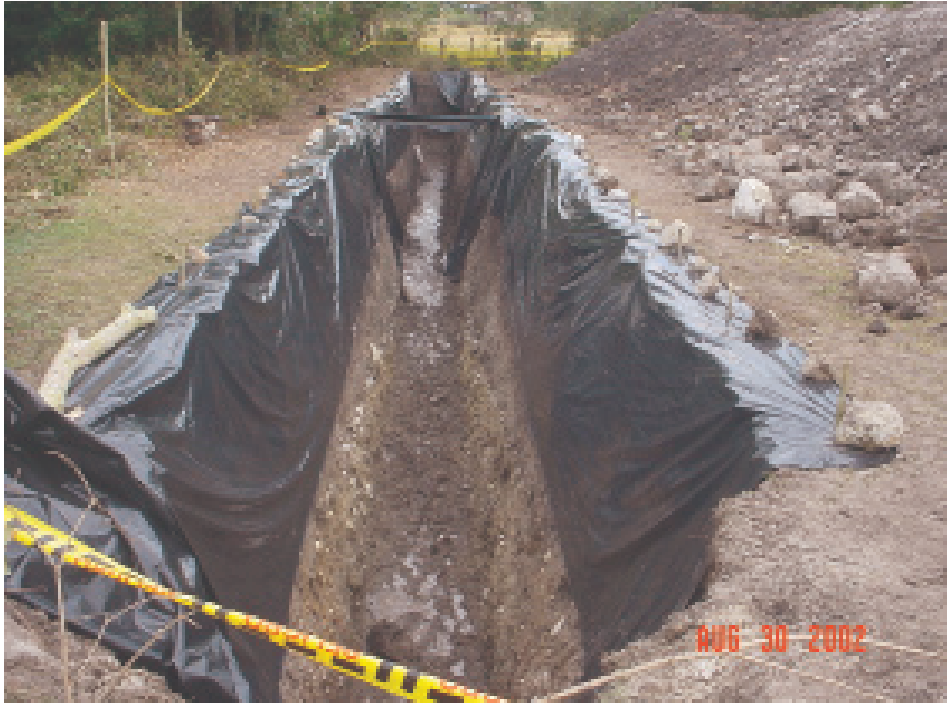
Figura 35. Protección de las paredes de la trinchera con plásticos.
