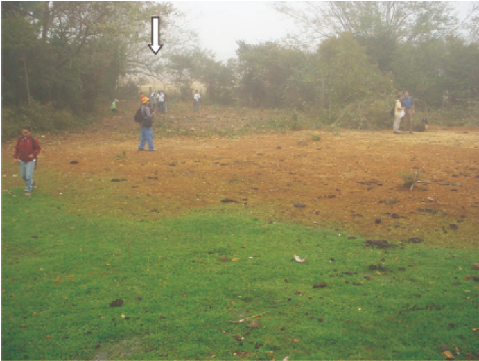
Figura 29. Sitio de trinchera después del descapote de la vegetación.
