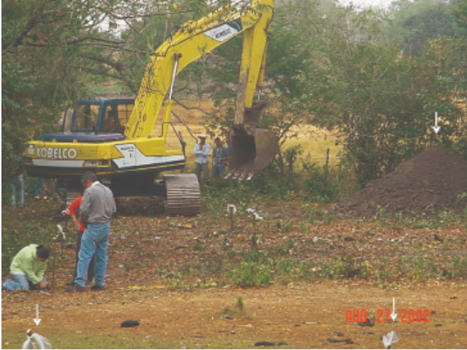
Figura 30. Inicio de la excavación de la trinchera de exploración paleosismológica Los Gomos. Las líneas de estacas delimitan, al este y al oeste, la zona que va a excavar.
