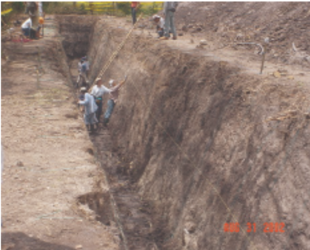
Figura 38. Trazado de la línea horizontal guía.
