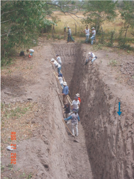
Figura 32. Trabajo de raspado y limpieza de las paredes. Observe las profundas marcas dejadas por la pala de la retroexcavadora.
