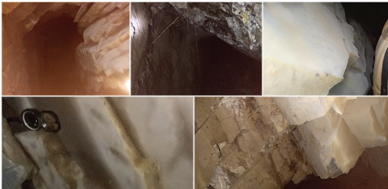
Fotografía 5.12. Mina artesanal La Cartera. Diaclasamientos identificados en la cruzada y guía de acceso
