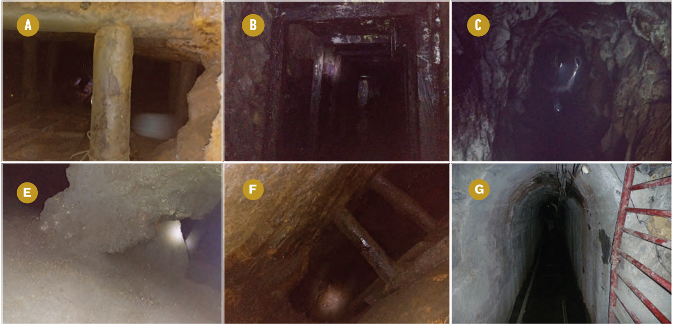
Fotografía 5.11. Sostenimiento utilizado en las minas artesanales del distrito minero de Frontino. A) medias puertas. B) puertas de madera. C) sostenimiento natural. D) cuñas irregulares. E) palancas. F) concreto reforzado en la mina El Apique
