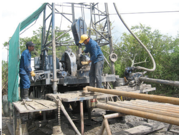
FIGURA 6. Perforación pozo profundo, municipio de Barichara (Santander). Foto. Jairo Veloza Franco, Ingeominas.
