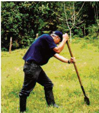
Inicio de apique
